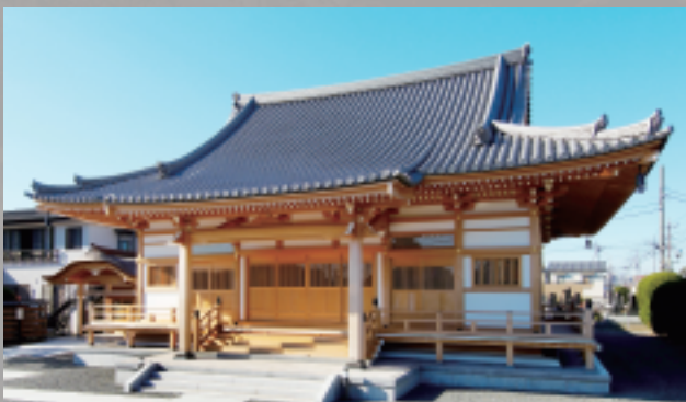
善應寺本堂新築工事 群馬県 自社設計
