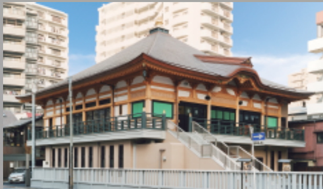
成田山川口分院本堂新築工事 埼玉県 設計：株式会社 池田社寺建築設計事務所
