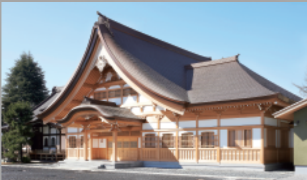
実相寺客殿新築工事 埼玉県 設計：株式会社 中村詔雄社寺建築設計事務所
